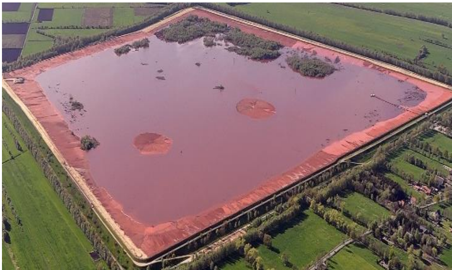
Figure 5 :Bauxite residue deposit in Germany ( https://de.wikipedia.org/wiki/Rotschlamm )
